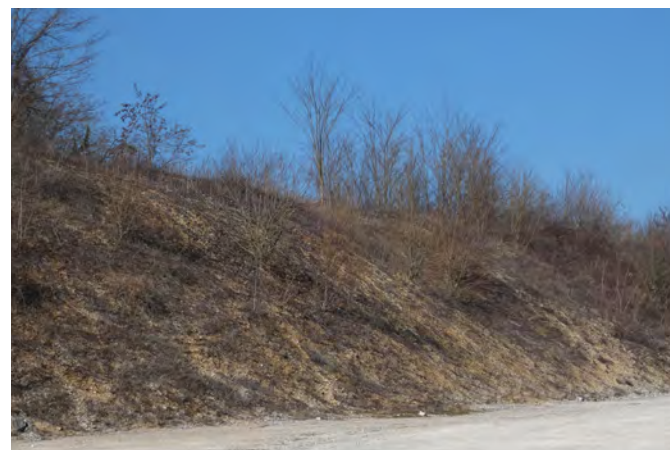
▲ Le front taluté en limite ouest actuel de l'excavation
