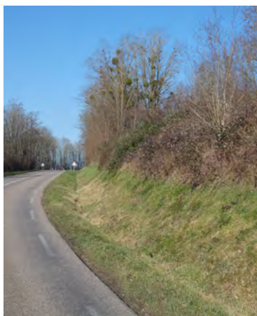
▲ Le merlon en bordure de la RD 2
